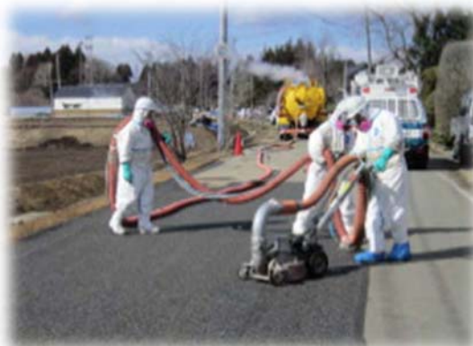
道路・駐車場の洗浄、切削等
